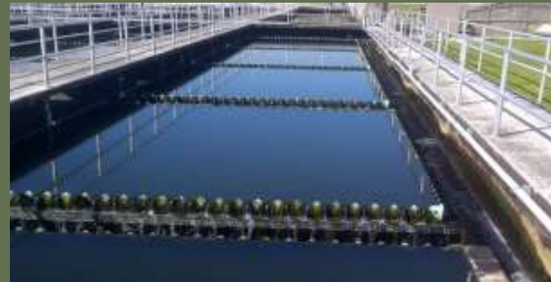
Строительство очистных сооружений поселка Снежногорск Срок реализации: 2016-2018 гг. Плановый объем инвестиций: 165,2 млн руб. Финансирование в 2018 г. (разработка ПСД): 3,64 млн руб.
