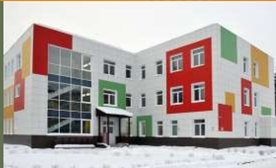
Реконструкция здания МБДОУ «Детский сад №69» (ул. Бауманская, 21) Срок реализации: 2014-2019 гг. Плановый объем инвестиций: 250,2 млн руб. Финансирование в 2018 г.: 136,0 млн руб.
